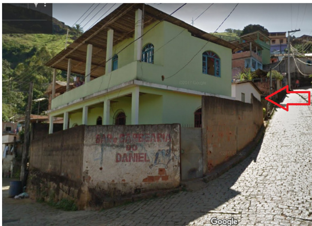
Rua Antônio Brandão - Nº 03 Casa limite - Família de Moradora Ignacia Ferreira.
