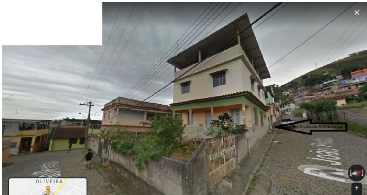
Rua Antônio Brandão - Nº 1 Casa Limite no segundo andar - Família de Josimar Massolari
