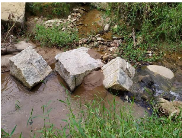
Foto 04: Vista dos blocos de granitos arrancados pela força das águas.
