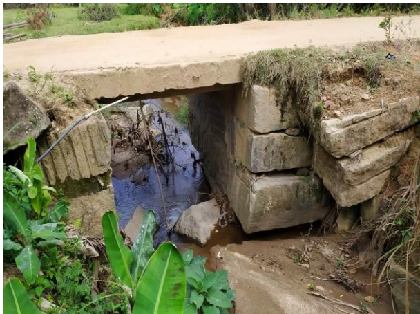
Foto 01: Vista do Local da ponte.
