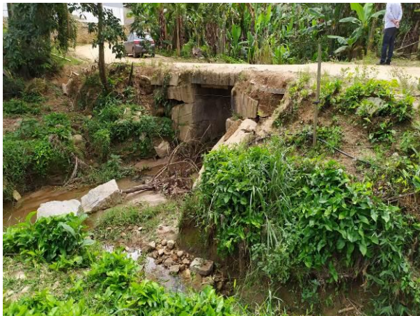
Foto 02: Vista da montante da ponte
