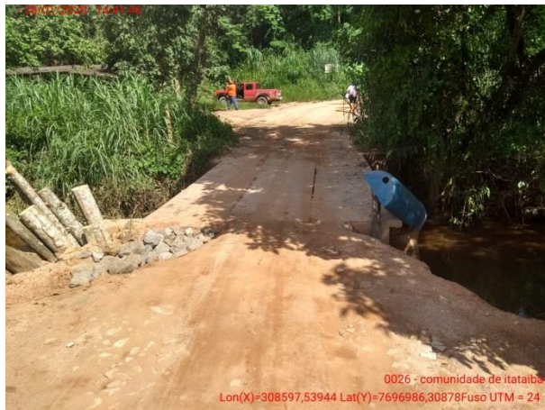
Foto 02: Vista do tabuleiro da ponte.
