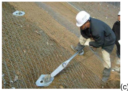
Figura 3-4:(a) diagramação dos grampos, espaçamento alternado (b) máxima área superficial instável e (c) torqueamento das placas
