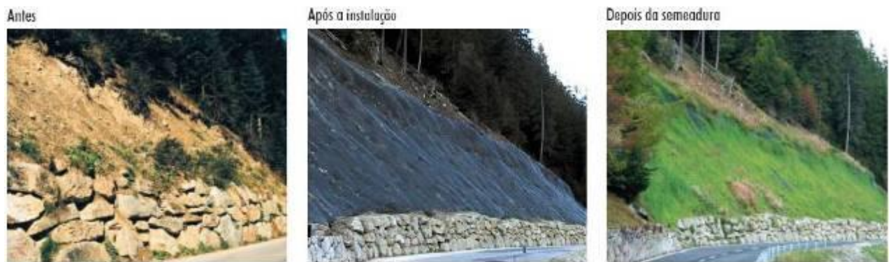
Figura 3-7: Aspecto anterior e posterior à instalação do sistema TECCO® com manta de controle de erosão TECMAT®
