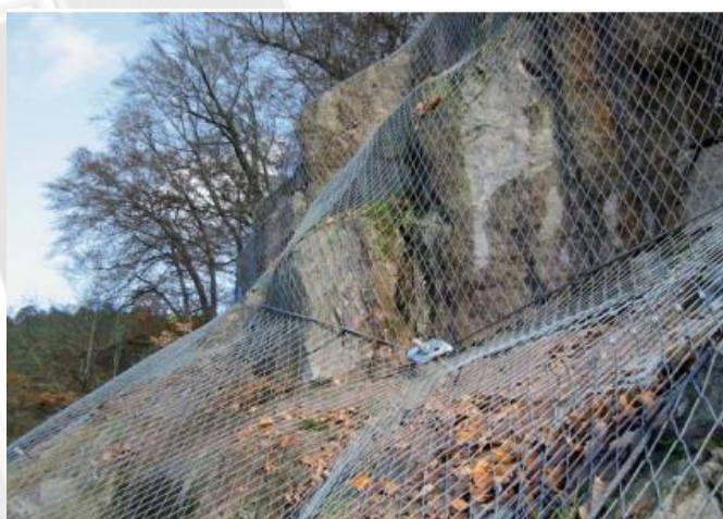
Figura 5 — Ilustração esquemática do sistema SPIDER.
